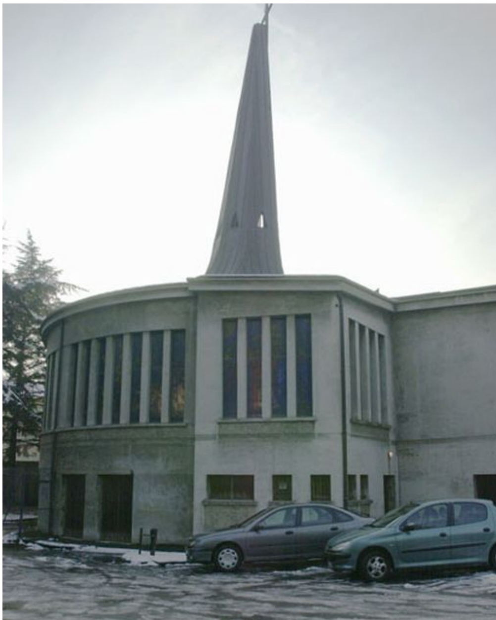
Vue générale du chevet depuis le nord
