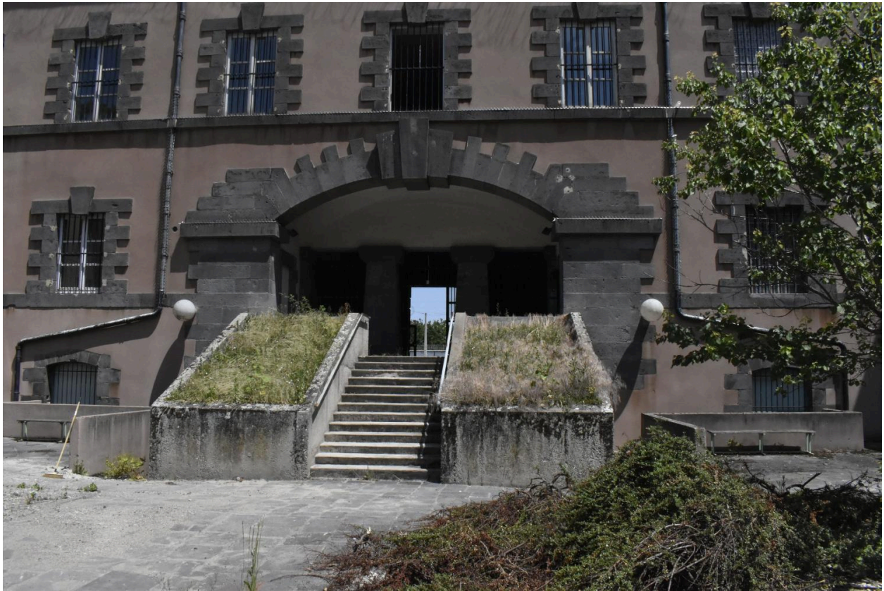
Partie centrale du bâtiment G dit de l'administration, depuis la cour est.
