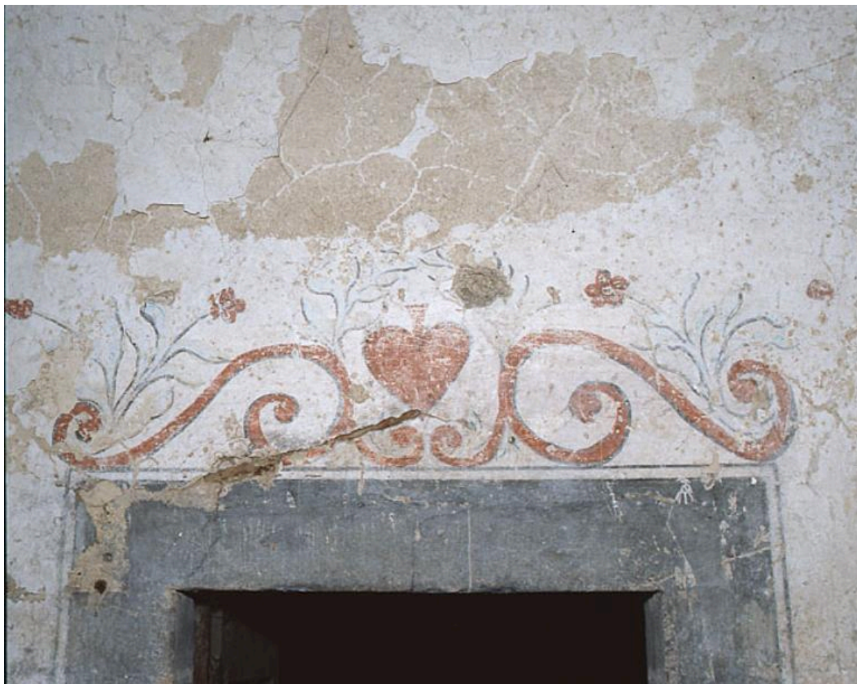
Détail du décor peint d'un dessus de porte au 2e étage de soubassement - préservé lors des travaux de 2008 (salle -2.2 du plan schématique).
