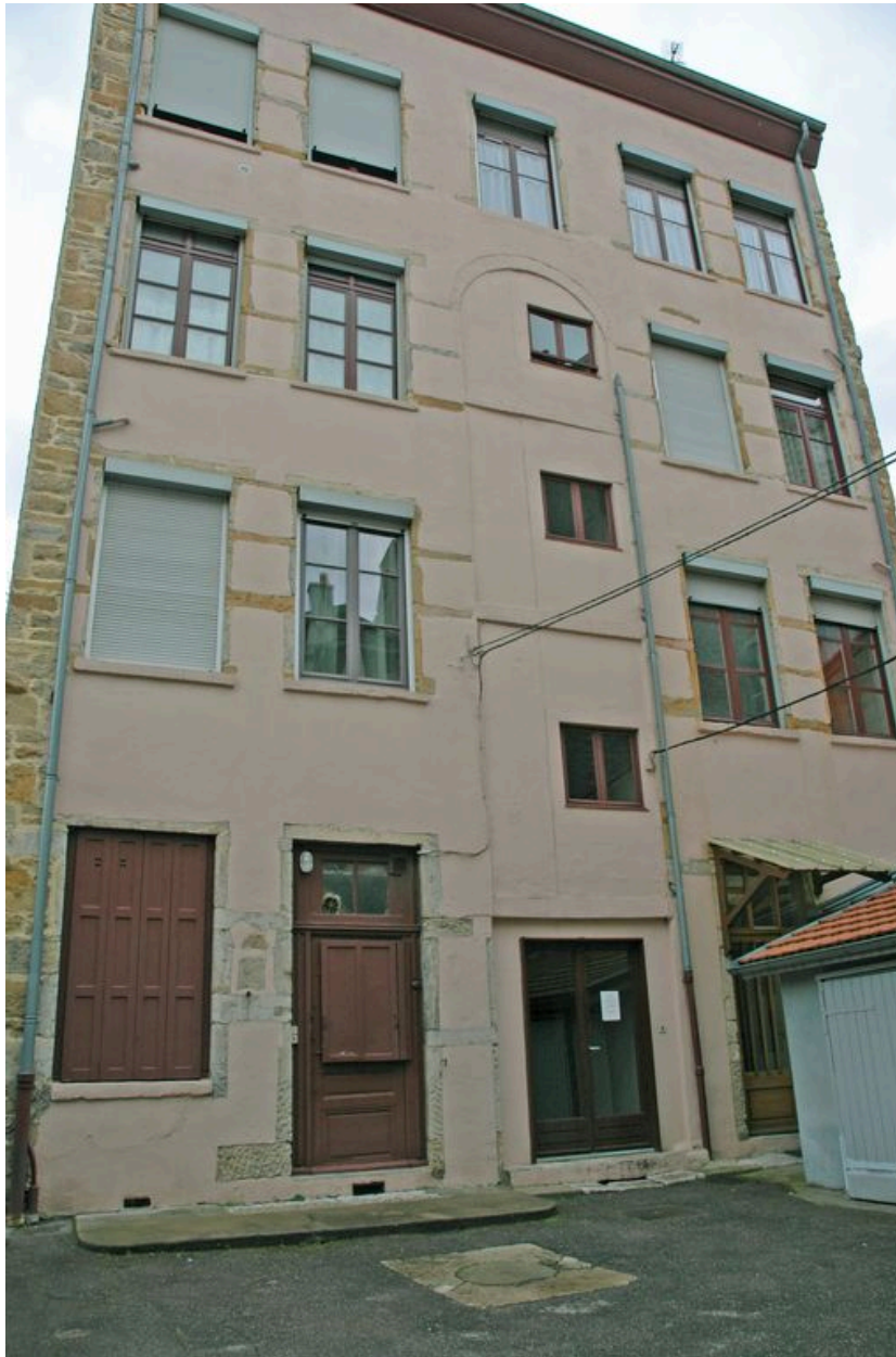
Façade ouest côté cour vue depuis le sud
