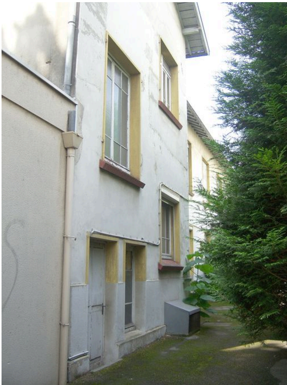
Bâtiment Nord Ouest, élévation postérieure
