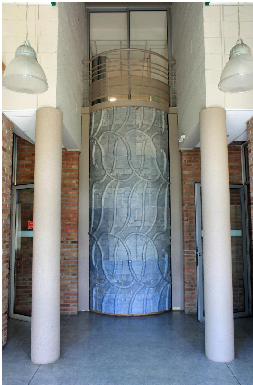
Billom, subdivision de la DDE, la cuve de stockage du fluide caloporteur dans le vestibule. Bas-reliefs créés par le sculpteur Jean Fonvieille.
