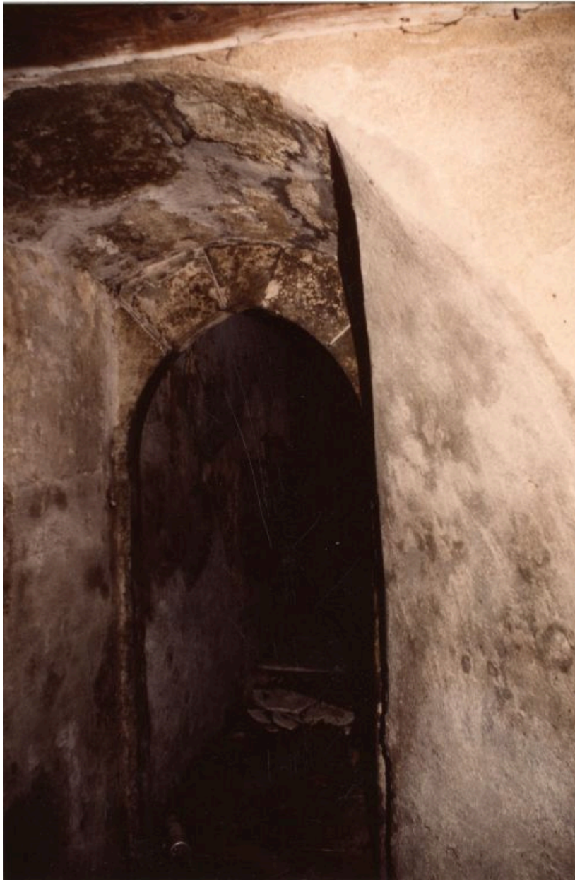
Porte dans le mur est, côté extérieur à la chapelle.
