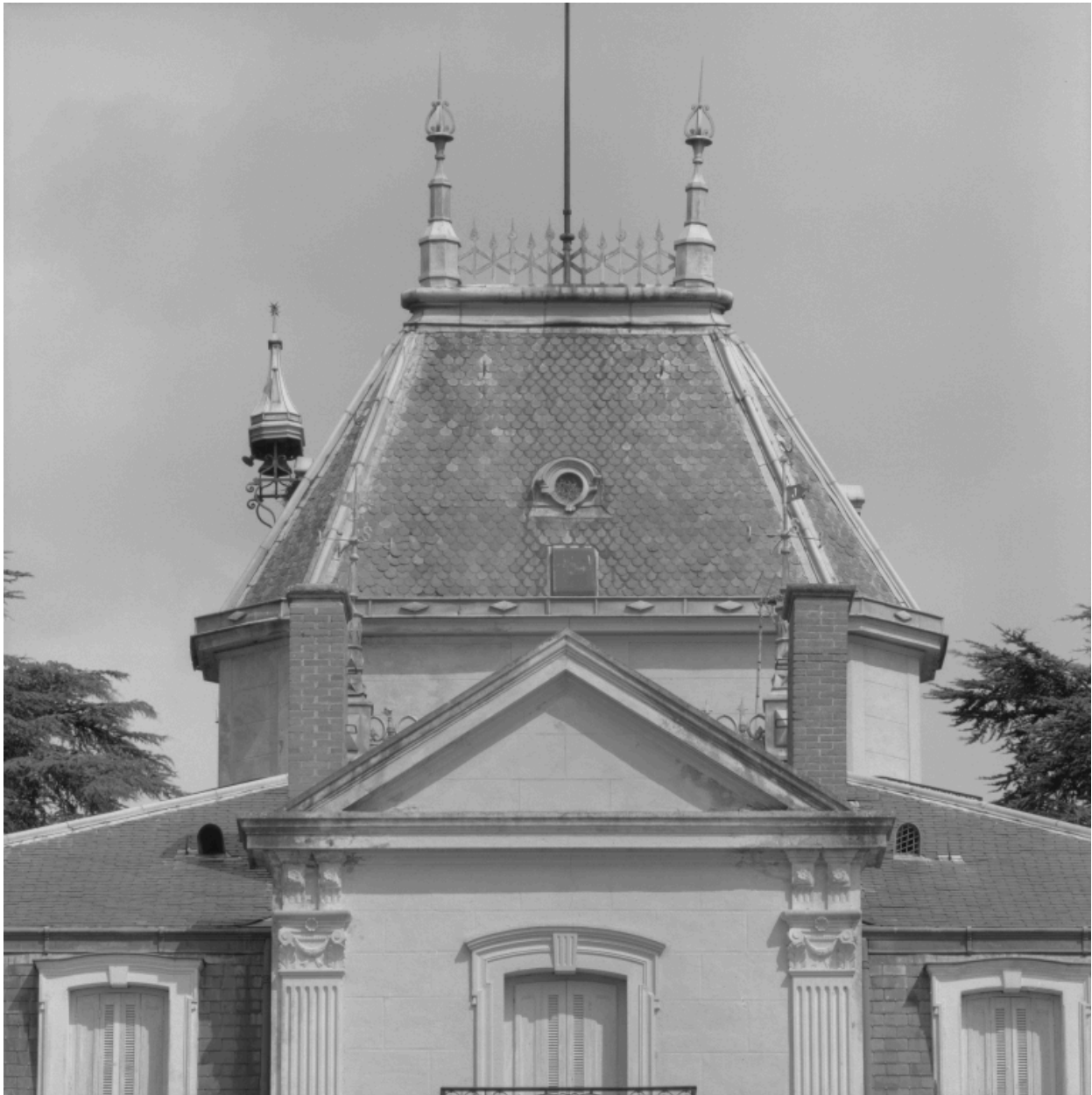
Vue du fronton de la façade antérieure et du couronnement de la tour d'escalier, depuis le sud.
