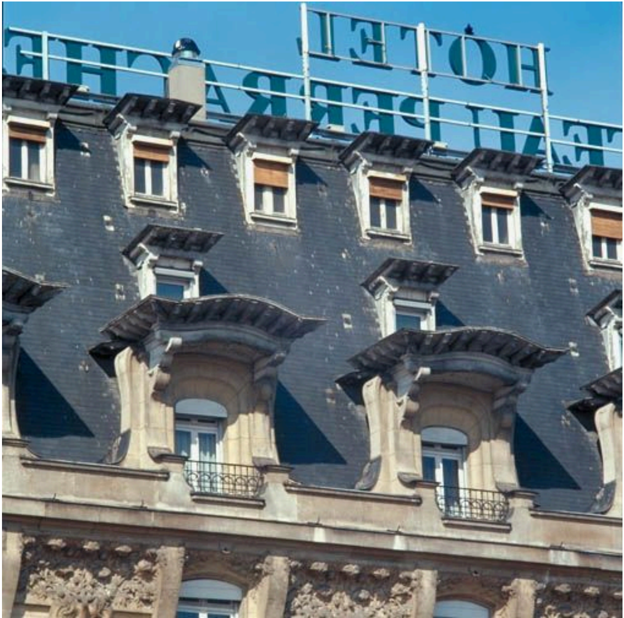
Détail des lucarnes des trois étages de comble
