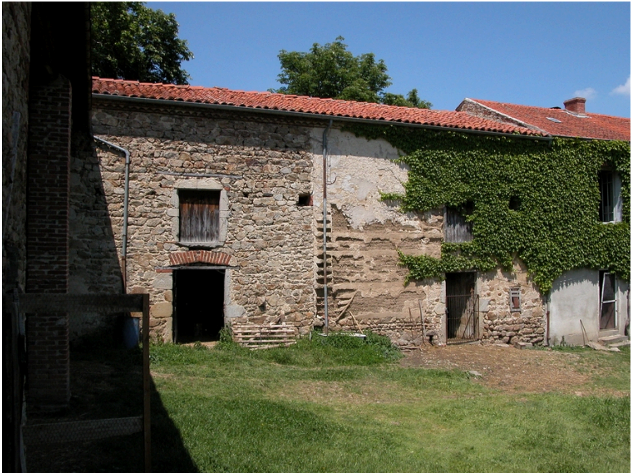
Vue d'ensemble de la grange-étable et de la remise, depuis le sud-ouest.
