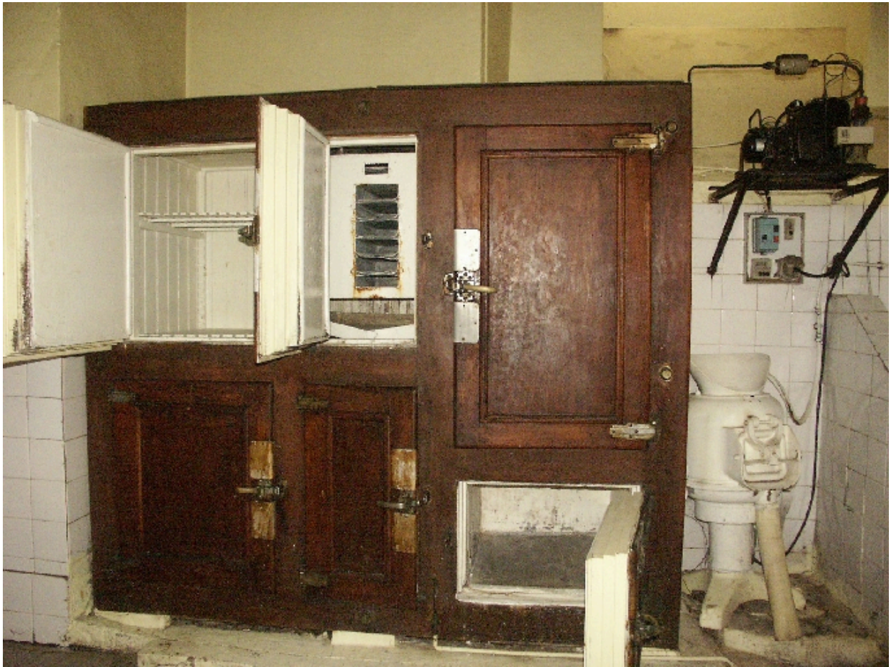
Cuisines : détail des placars-réfrigérants
