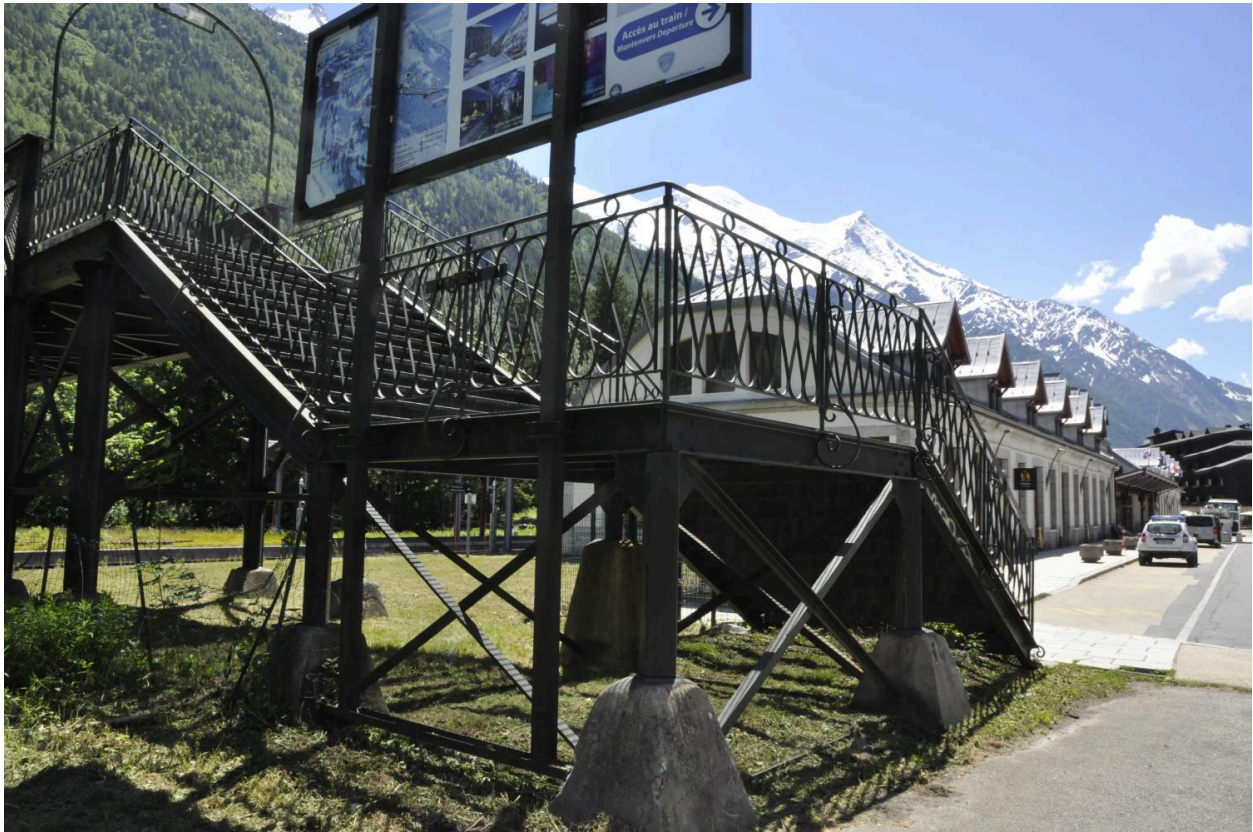
Vue des croix de Saint-André supportant l'escalier
