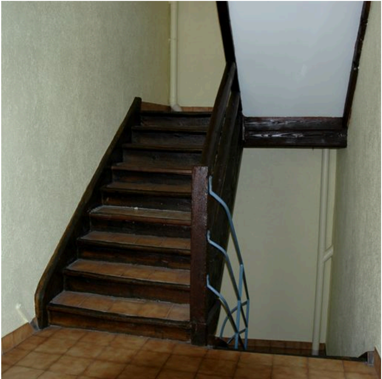
Volée de l'escalier au 3e étage avec rampe en bois
