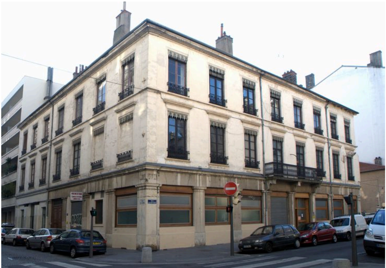
Elévation antérieure et latérale du 37 rue Vaubecour depuis le nord-ouest
