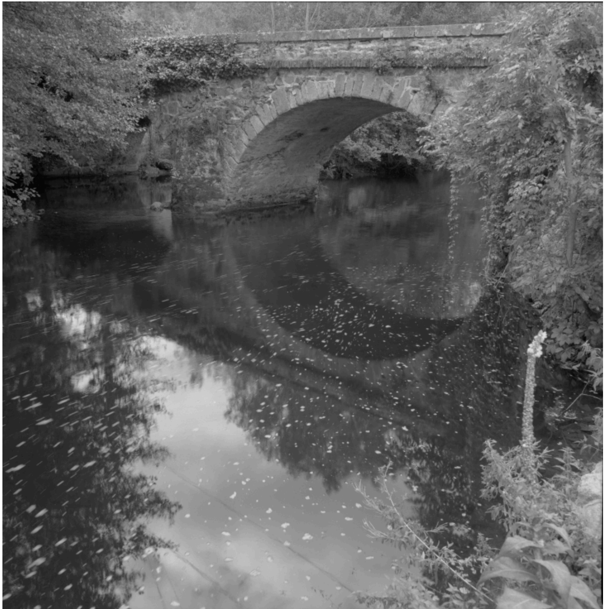
Pont au-dessus du Lignon, détail des culées.
