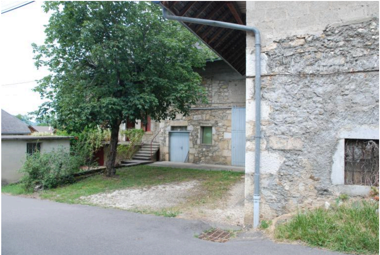
Vue d'ensemble de la ferme 2017 A1 34, 35 (non repérée), depuis le sud-est.
