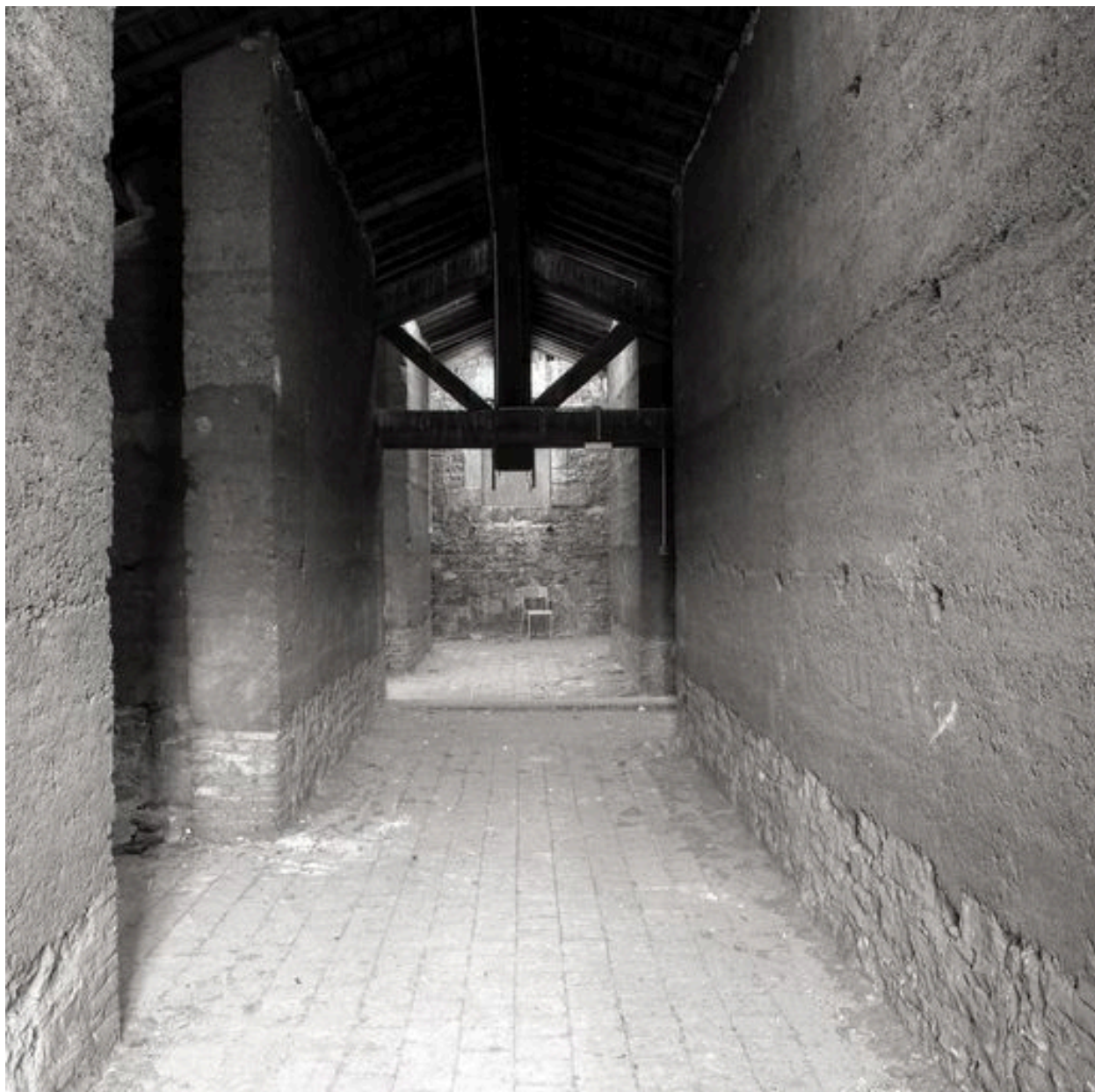
Ecole de garçons. Les combles, avec partie supérieure des murs en mâchefer.
