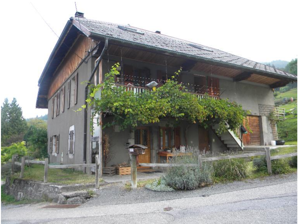
Vue d'une ancienne ferme crépie au ciment (2008 E8 2420).
