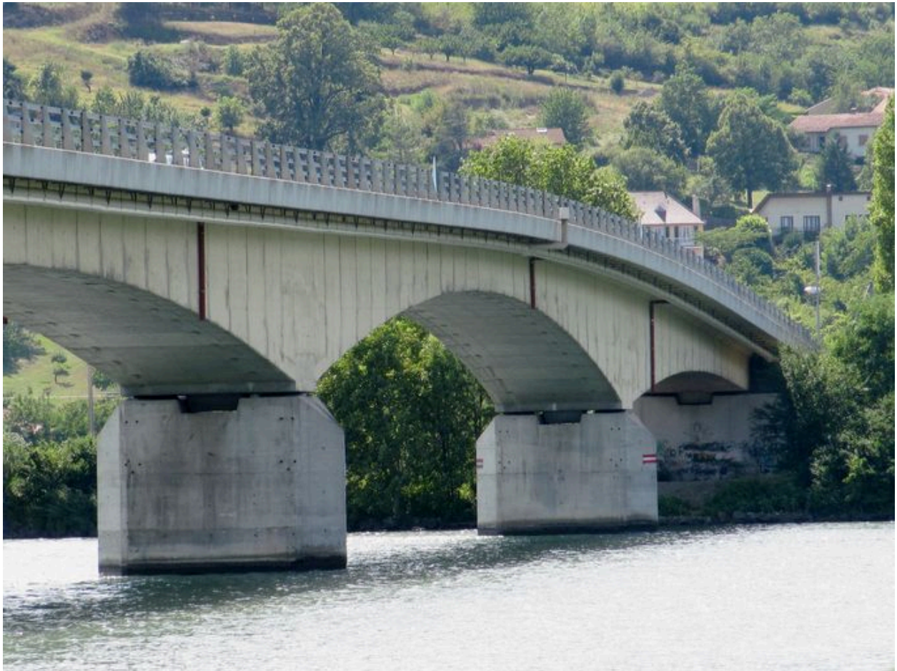
Vue partielle, de côté, culée et travées dextres, face amont (depuis la rive gauche)
