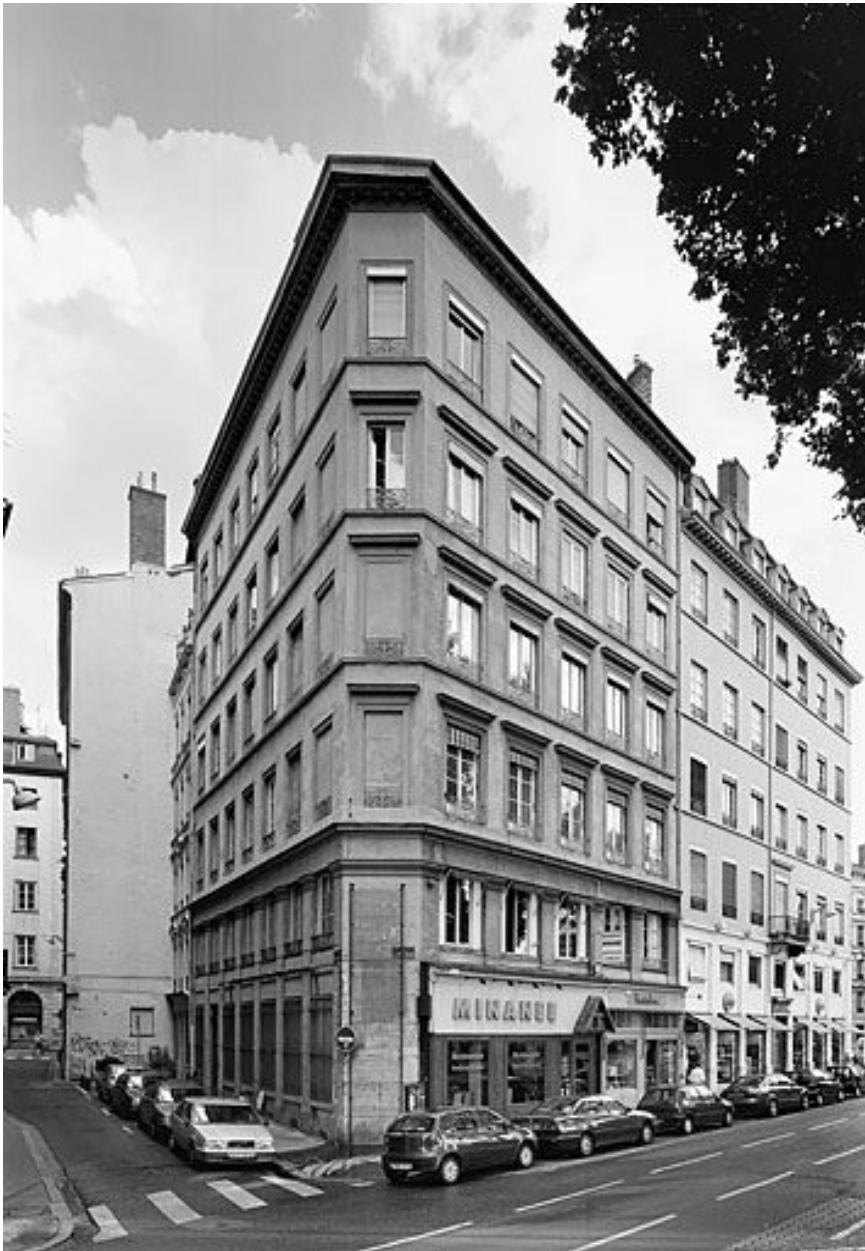
Vue générale des façades
