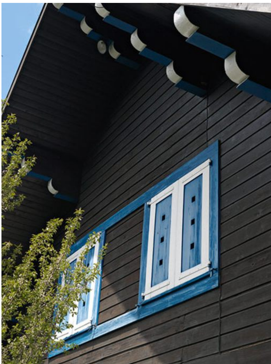
Détail des baies de la façade sud
