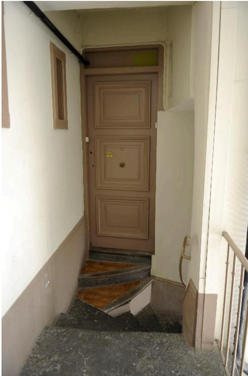
Immeuble sur rue, porte secondaire ajoutée sur le premier palier
