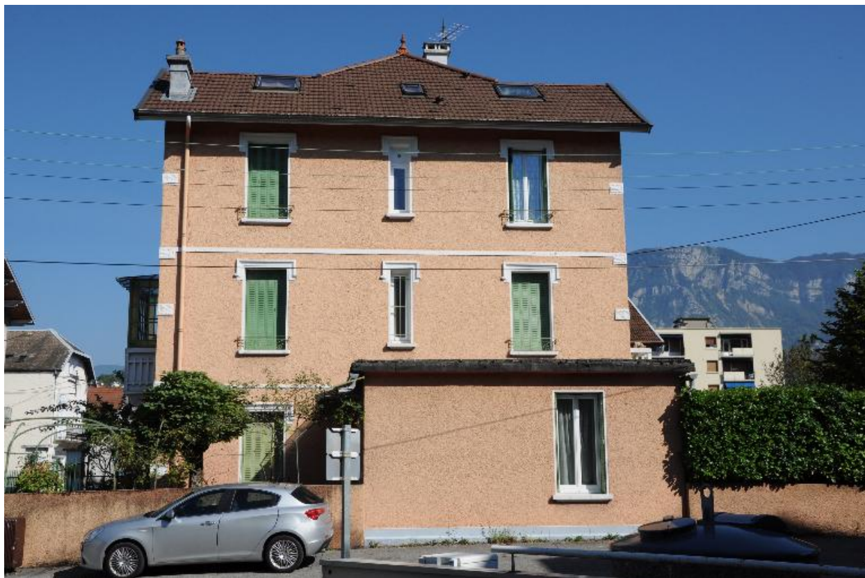
Façade latérale ouest
