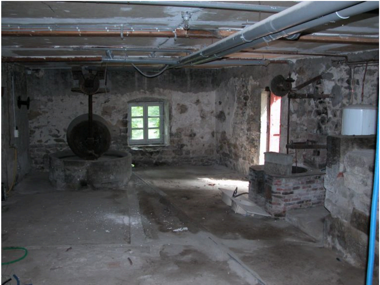
Etage de soubassement, vue intérieure sud avec les meules à broyer les noix et la cuve à chauffer les noix broyées.
