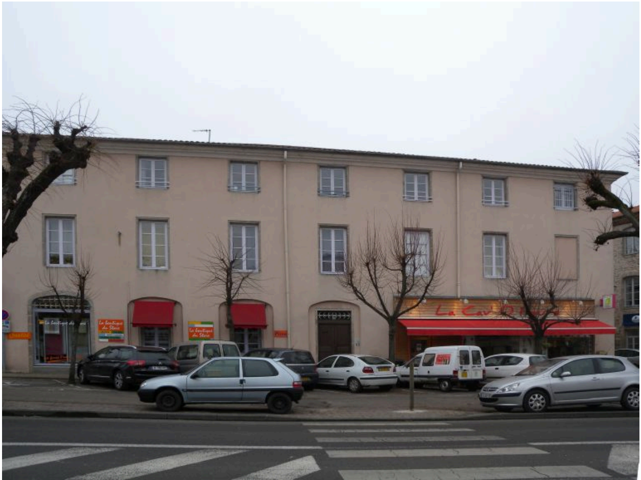
Vue générale de l'immeuble construit sur les anciennes fortifications, boulevard de la Madeleine.
