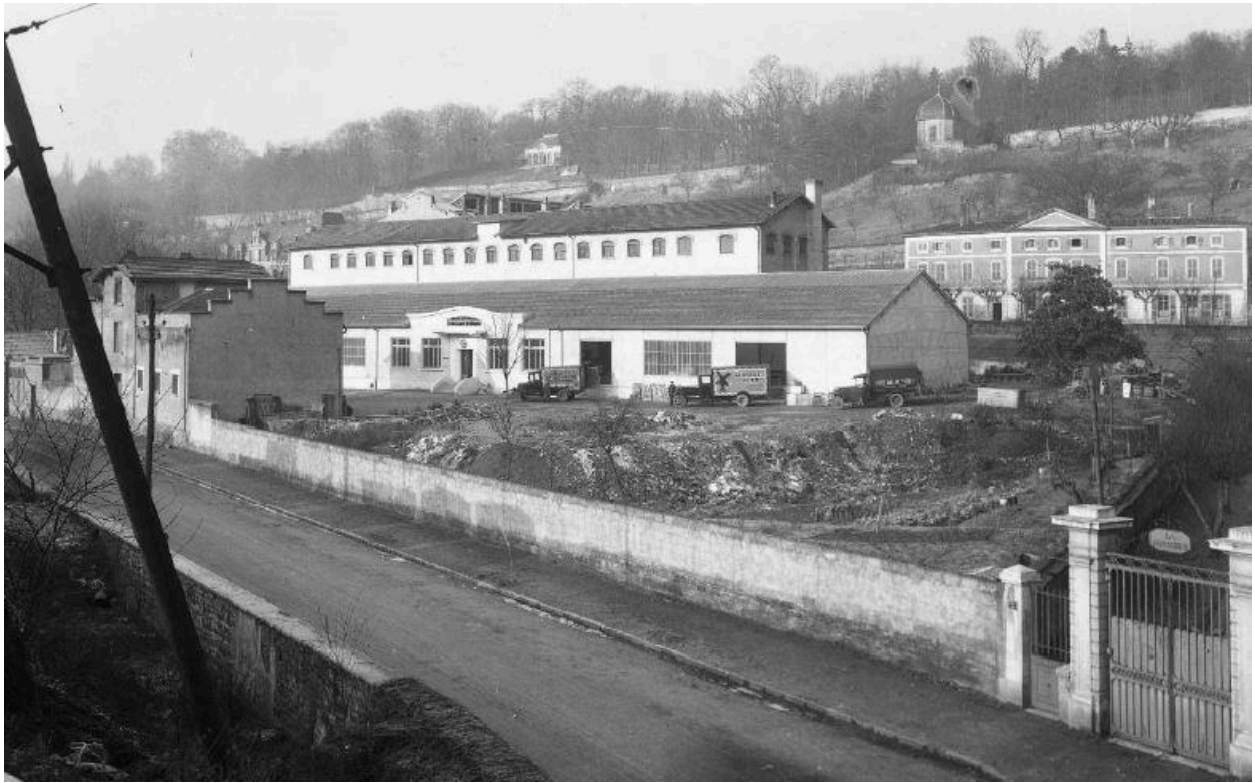
Vue de la minoterie Millat rue Mouillard à Vaise (archive privée)
