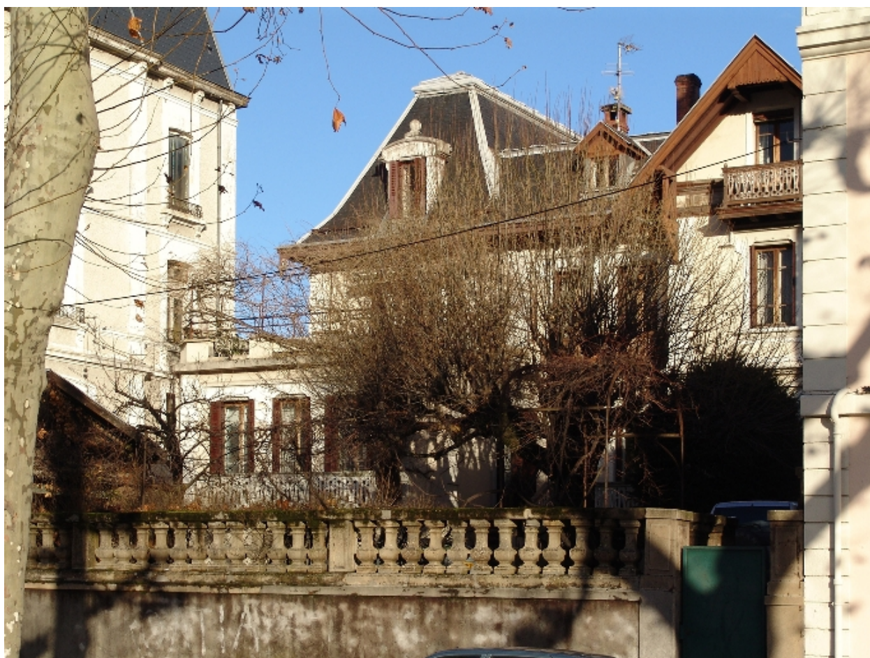
Façade postérieure, vue de trois-quart
