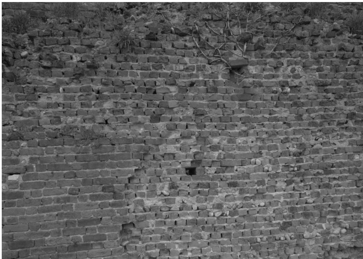
Détail, appareil en carrons du mur d'enceinte.
