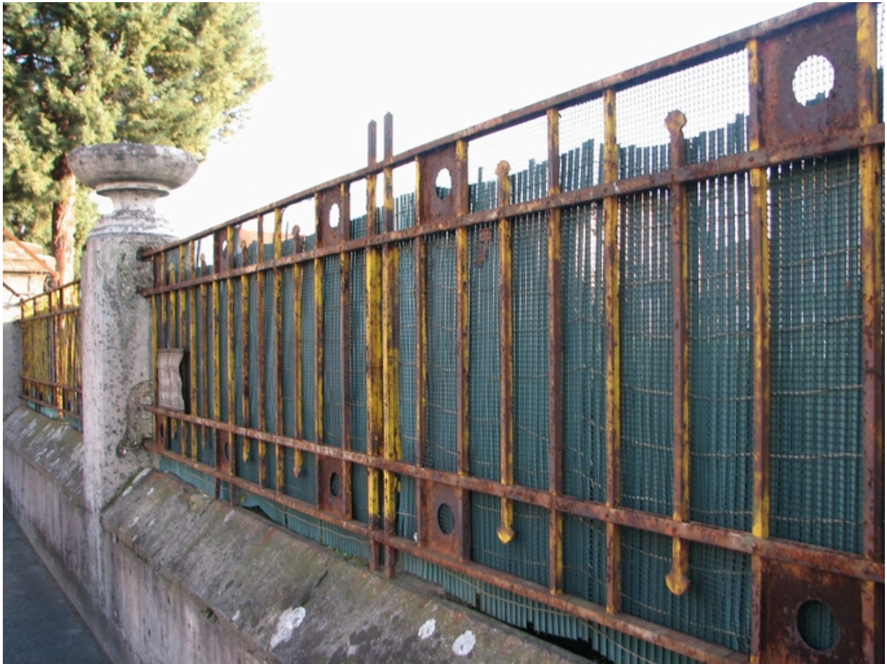
Clôture : muret surmonté d'une grille en ferronnerie rythmée par des colonnes surmontées d'un vase
