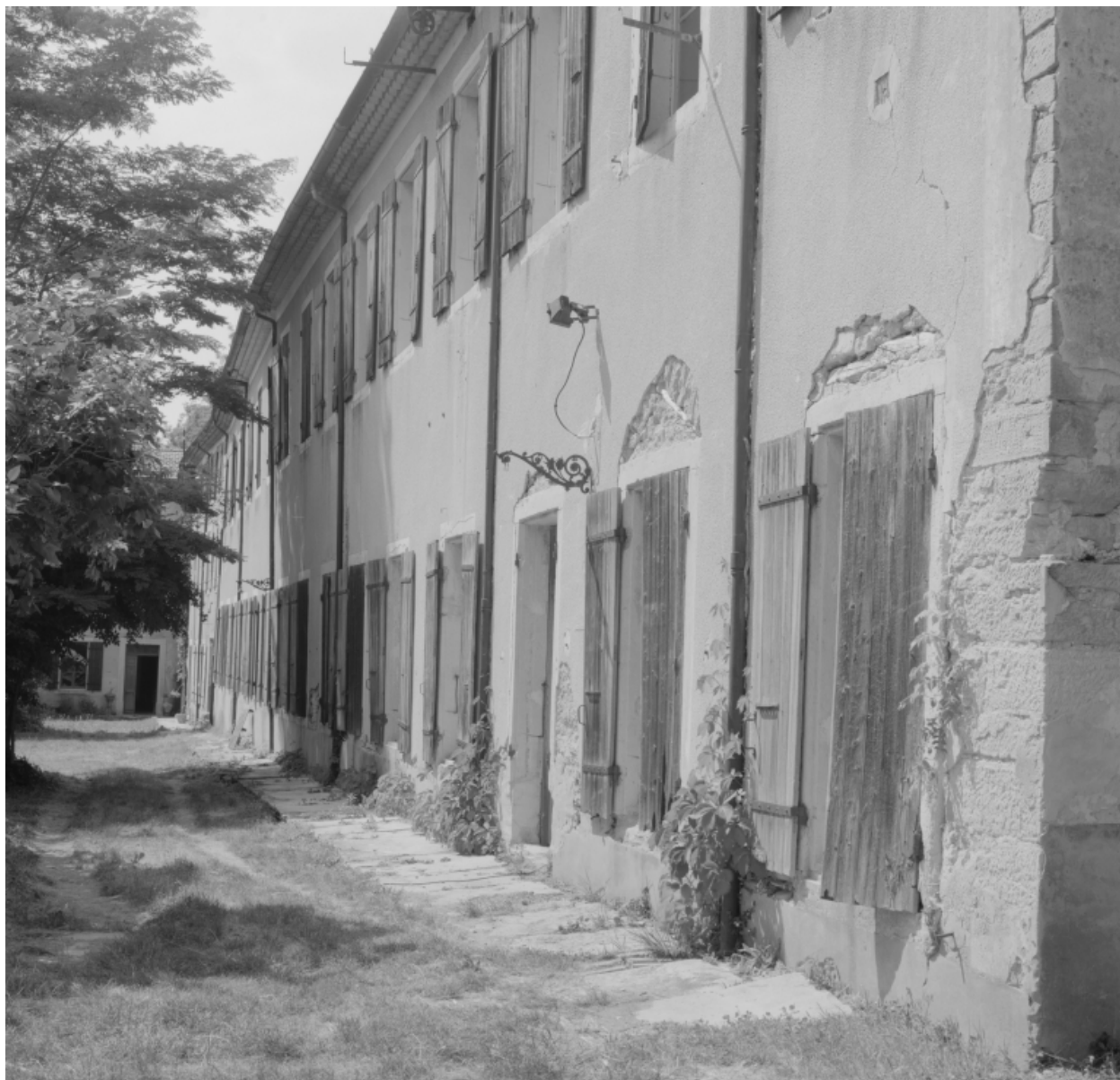
Aile nord, anciens ateliers de moulinage, façade.
