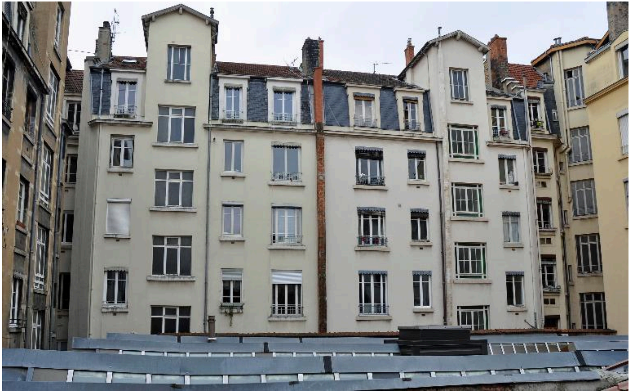
Elévations sur cour des 5-7, rue de Bonald (immeubles en miroir)
