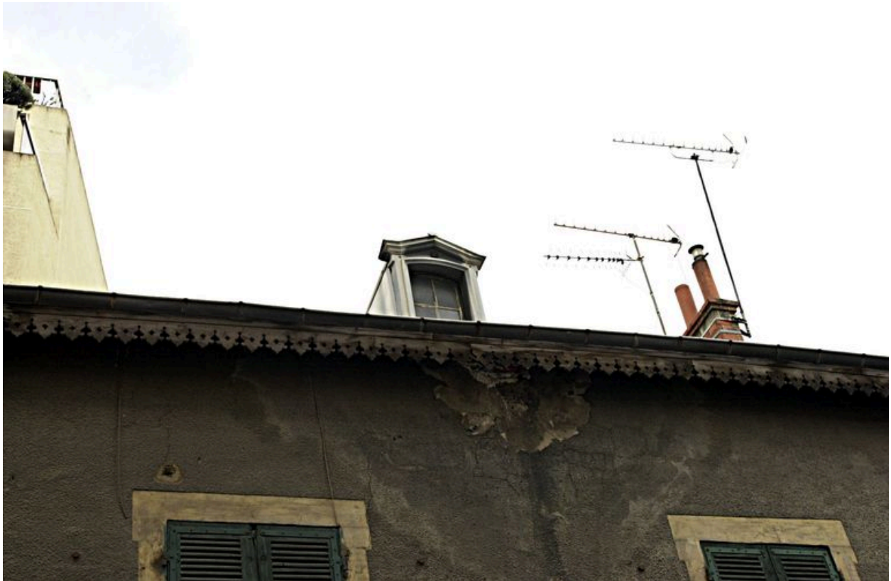
Logis, façade sur rue, détail du lambrequin de l'avant-toit
