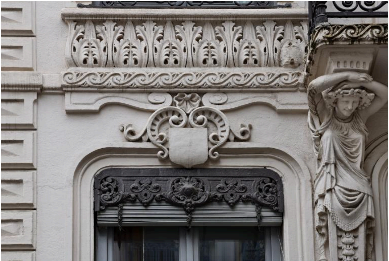
Elévation rue de Brest, premier étage carré : frise d'acanthes, cartouche, écusson muet, lambrequin et terme féminin
