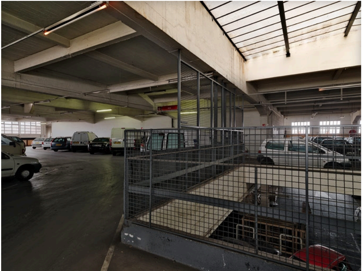
Fosse d'éclairage entre le 4e au 3e étage
