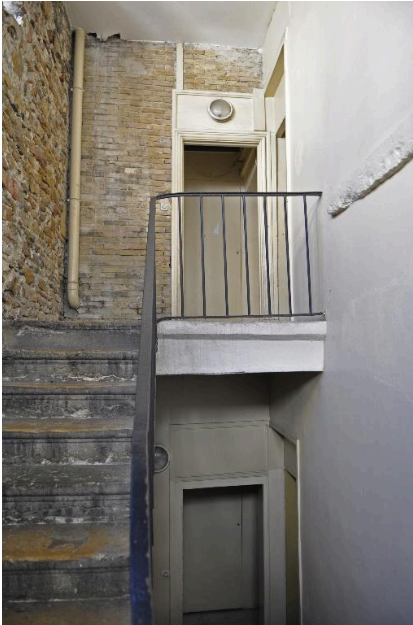
Vue du dernier palier, surélévation en briques plates
