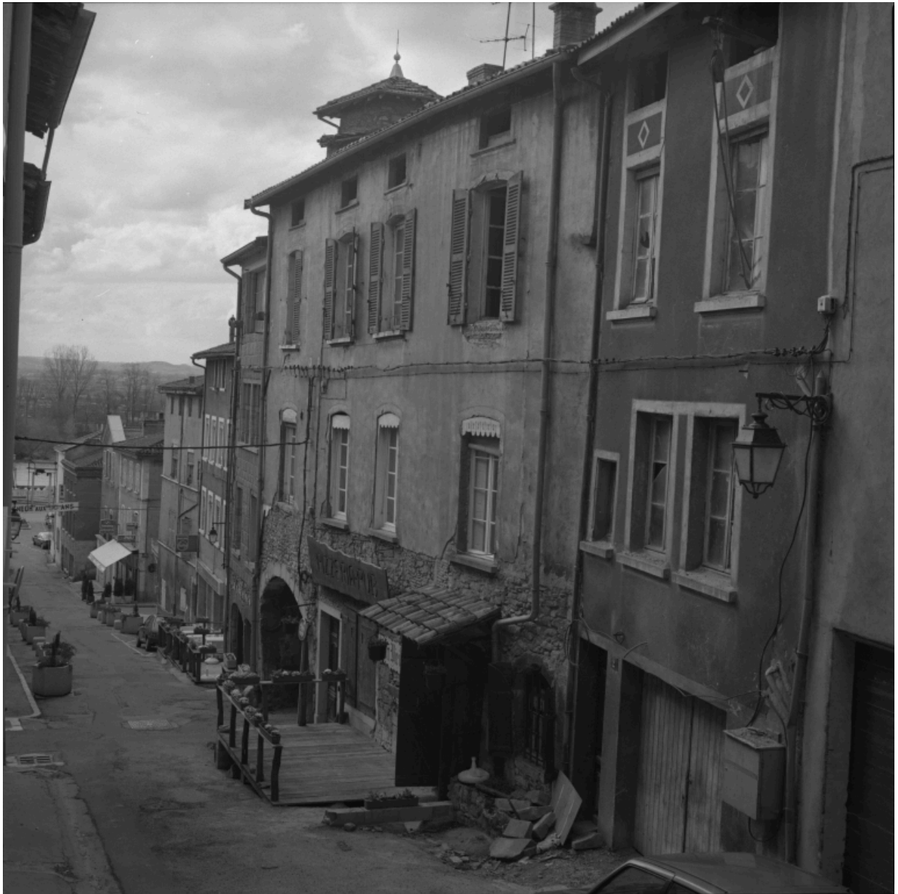
Élévation sur la rue du Port, de l'immeuble au n°4, avec passage couvert dit La Voûte
