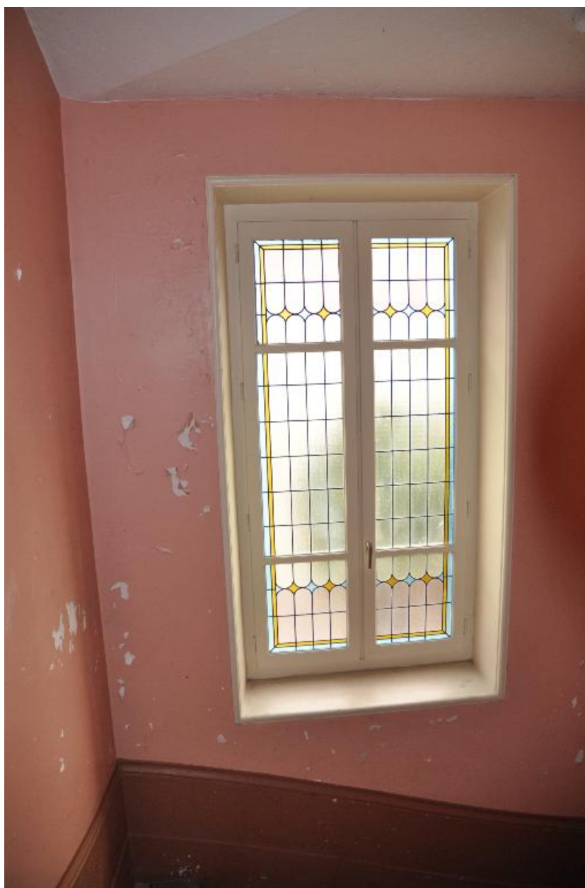
Vue d'une baie de la cage d'escalier
