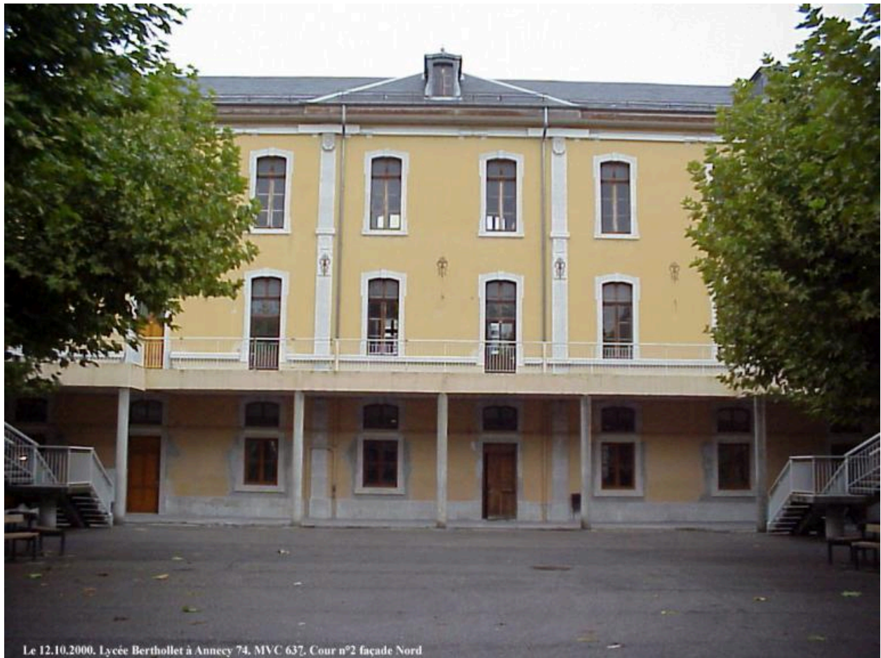
État en 2000 : cour 2, façade bâtiment 19e
