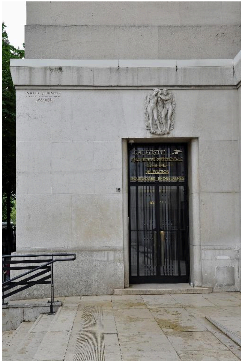
Elévation nord : rez-de-chaussée surélevé en retrait de façade au 10 place Antonin-Poncet
