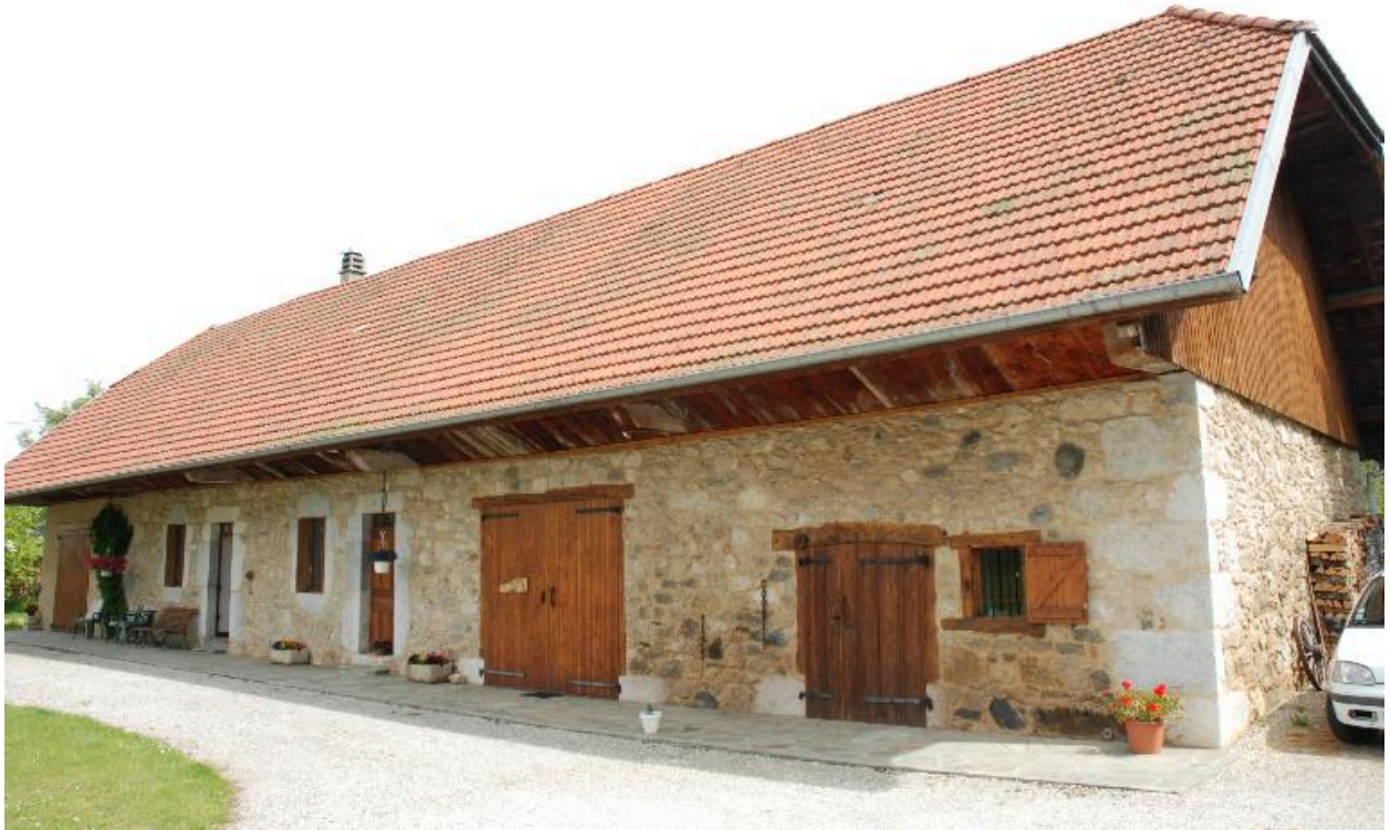
Vue d'ensemble de la ferme.
