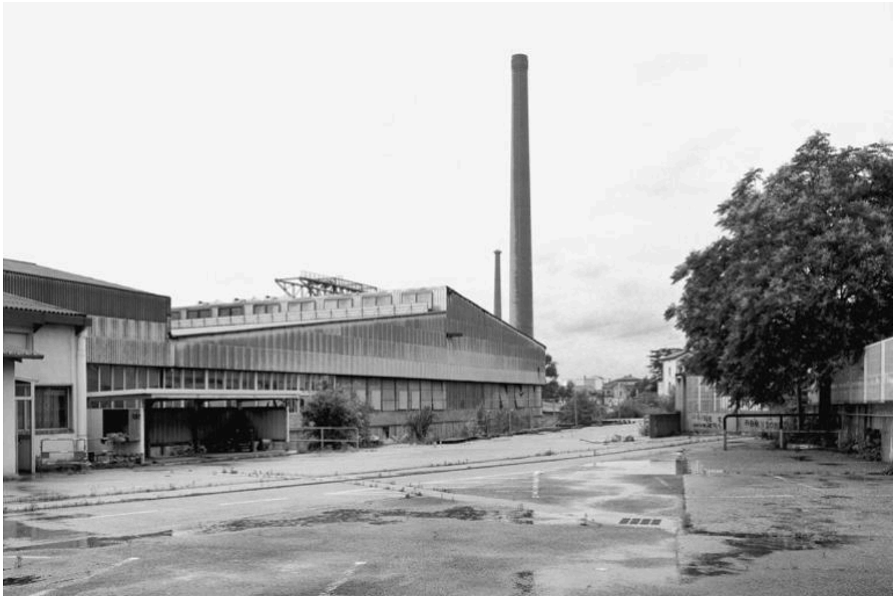
Vue d'ensemble de la verrerie avec la cheminée
