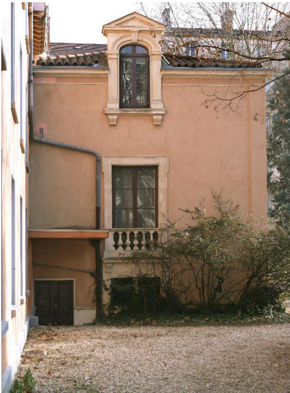
L'ancienne maison forte : l'élévation nord, sur le jardin.
