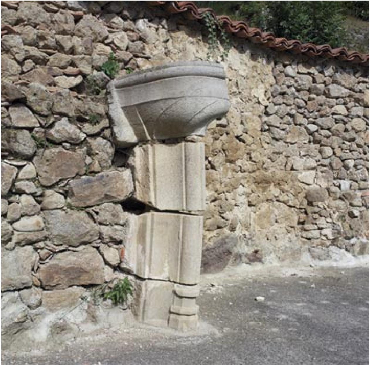
Piédroit de cheminée remonté (au niveau du rez-de-chaussée surélevé, dans une partie détruite).
