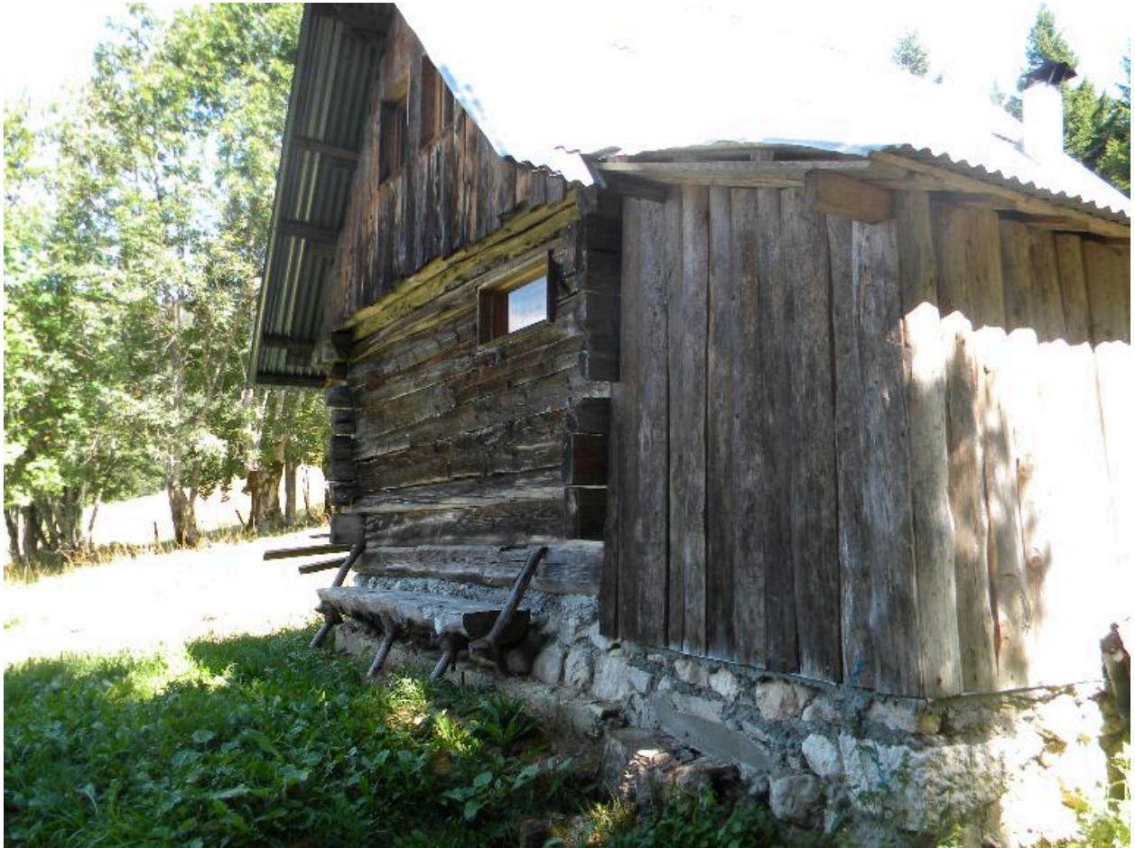
Vue d'une extension en façade est.
