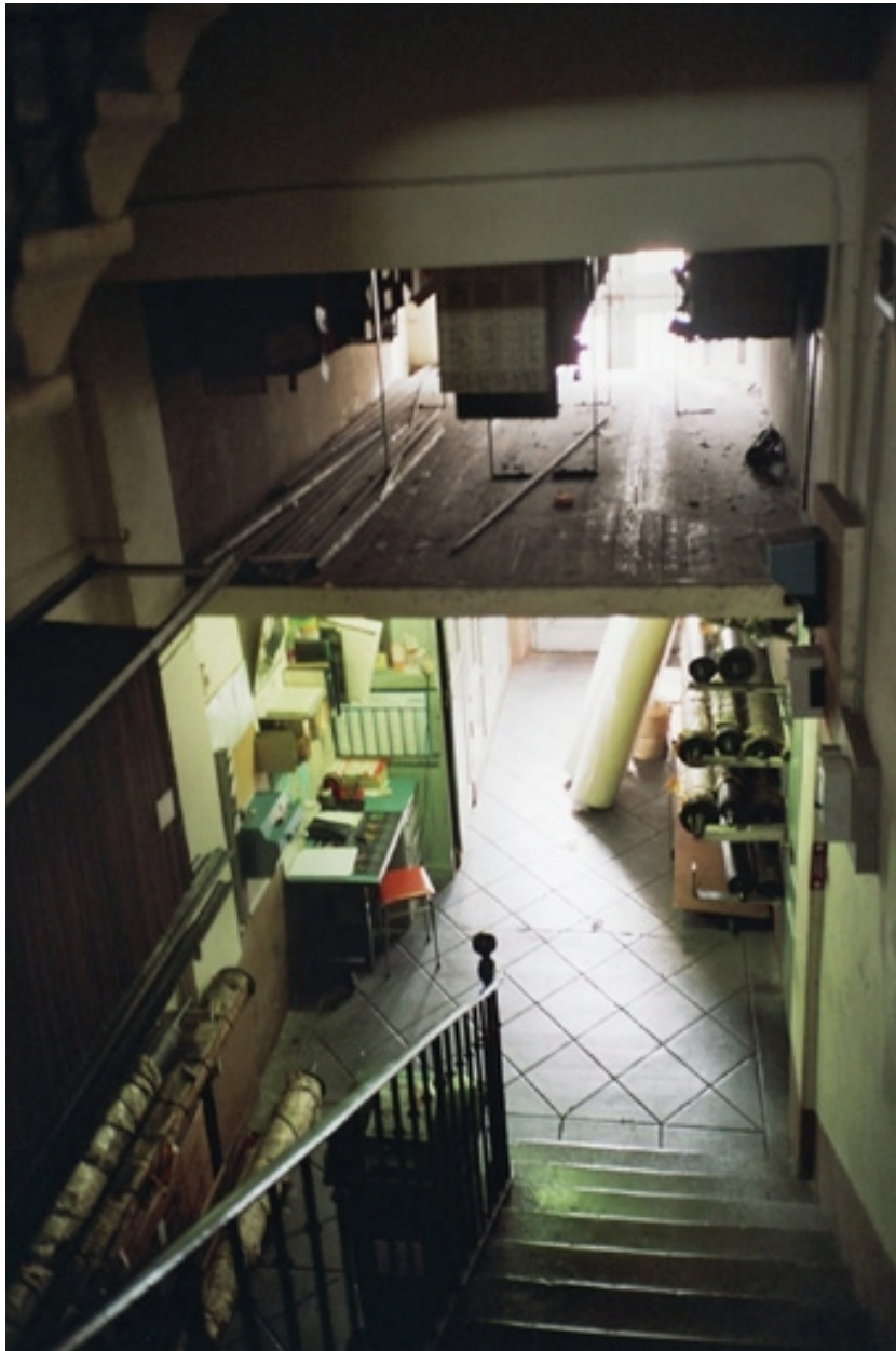
Escalier intérieur et stockage des cartons perforés en mezzanine
