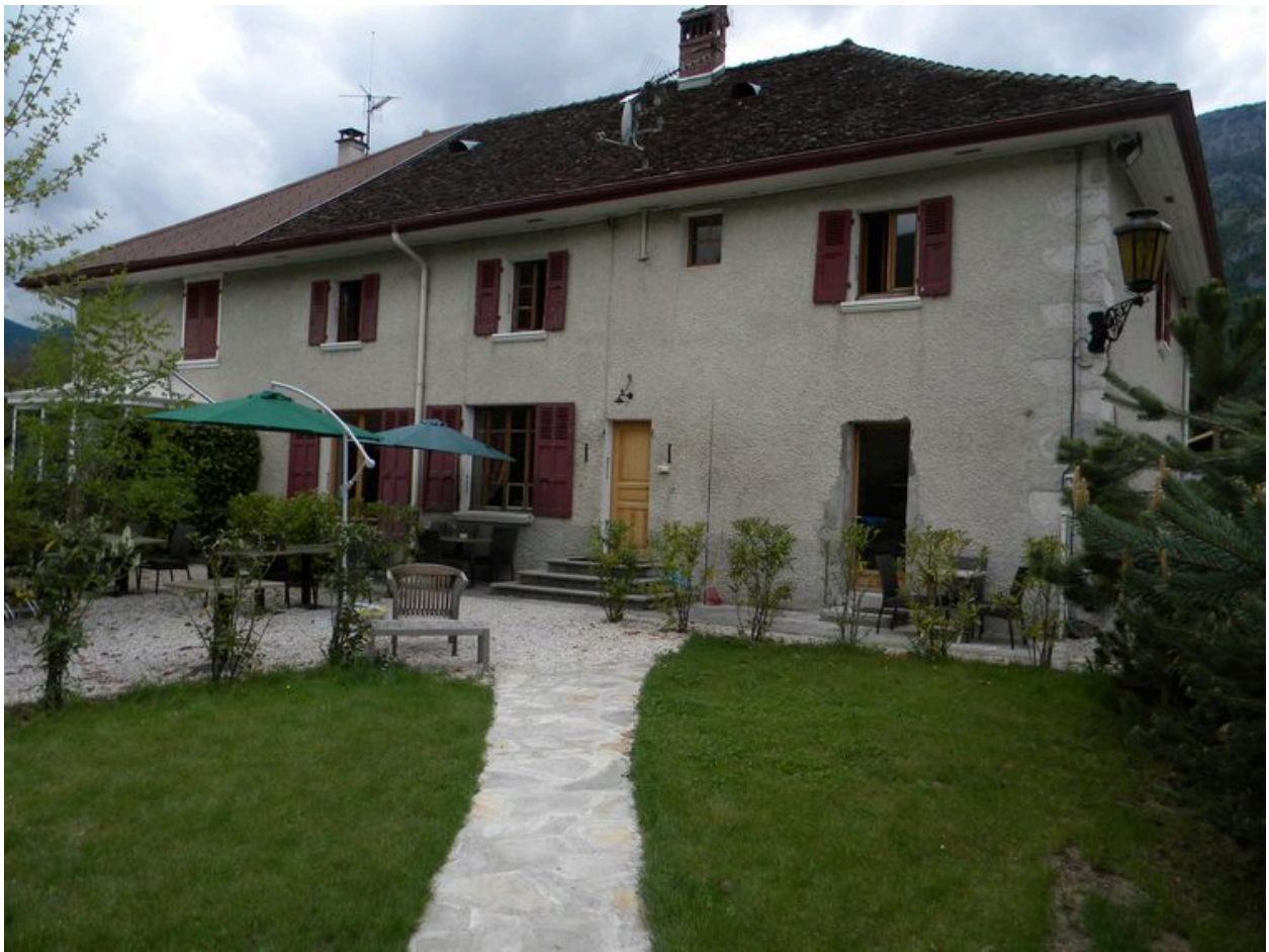
Vue de la façade arrière.
