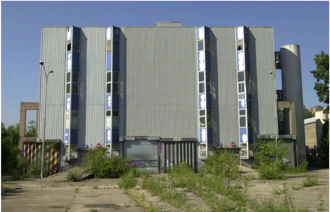
Vue générale depuis le nord, avec l'arrivée des voies ferrées
