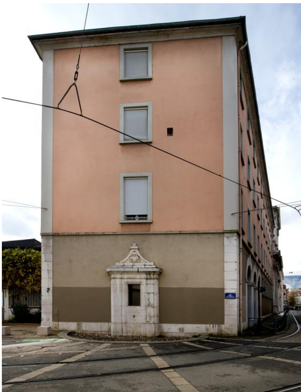
Corps de bâtiment 19e : élévation est et fontaine dite des jésuites
