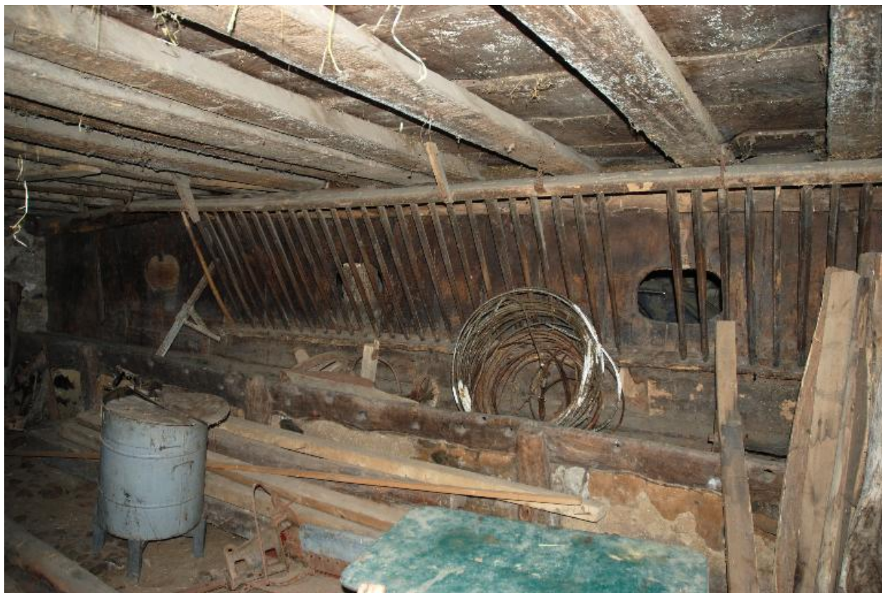
Vue intérieure de l'étable.
