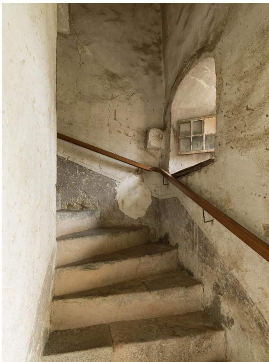
Vue intérieure de l'escalier : 1ère volée.
